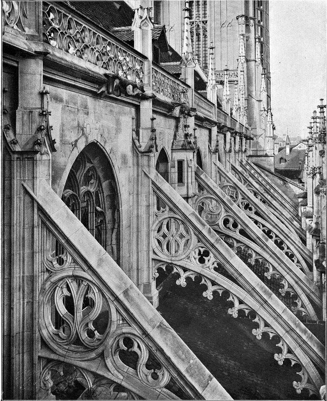
Strebebogen an der Nordseite des Münsters
