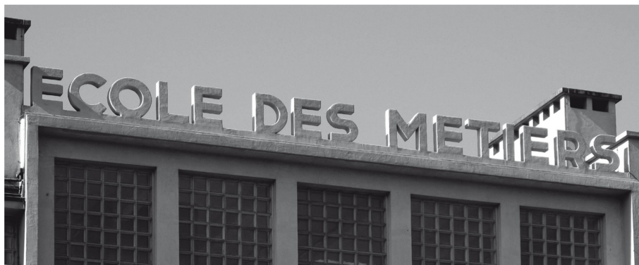
1 Lausanne, Ecole des métiers, détail de la façade principale (Photo D. Lütthi).
