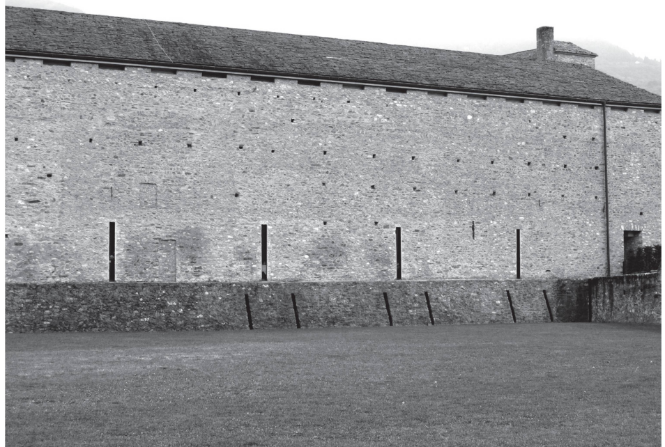
3 Bellinzone, Castelgrande, aile ouest avec les ouvertures percées par Aurelio Galfetti lors de la restauration de 1981-1991 (photo D. Lüthi).
