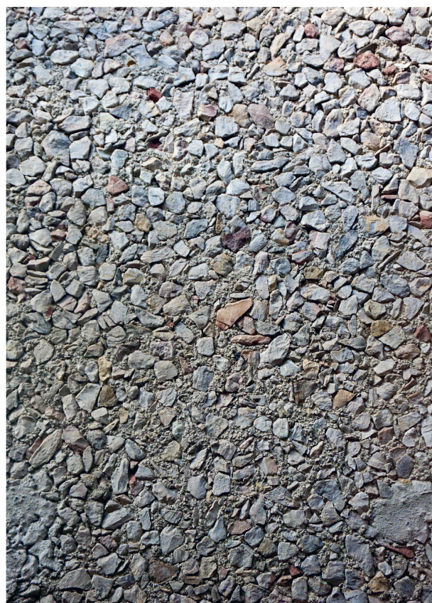
9 Détail d'un panneau préfabriqué en béton lavé du Valentin (photo Aline Jeandrevin, 2019).
