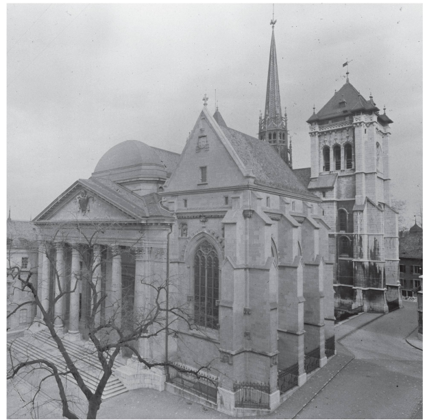
2 Chapelle des Macchabées à Genève, état vers 1960, après la dérestauration de Frédéric Gilliard en 1939 (suppression du garde-corps monumental et des ornements du fronton, réfection de la toiture) (BGE, CIG, inv. BG 43.1, photo Georges Maurice Jaeger).
