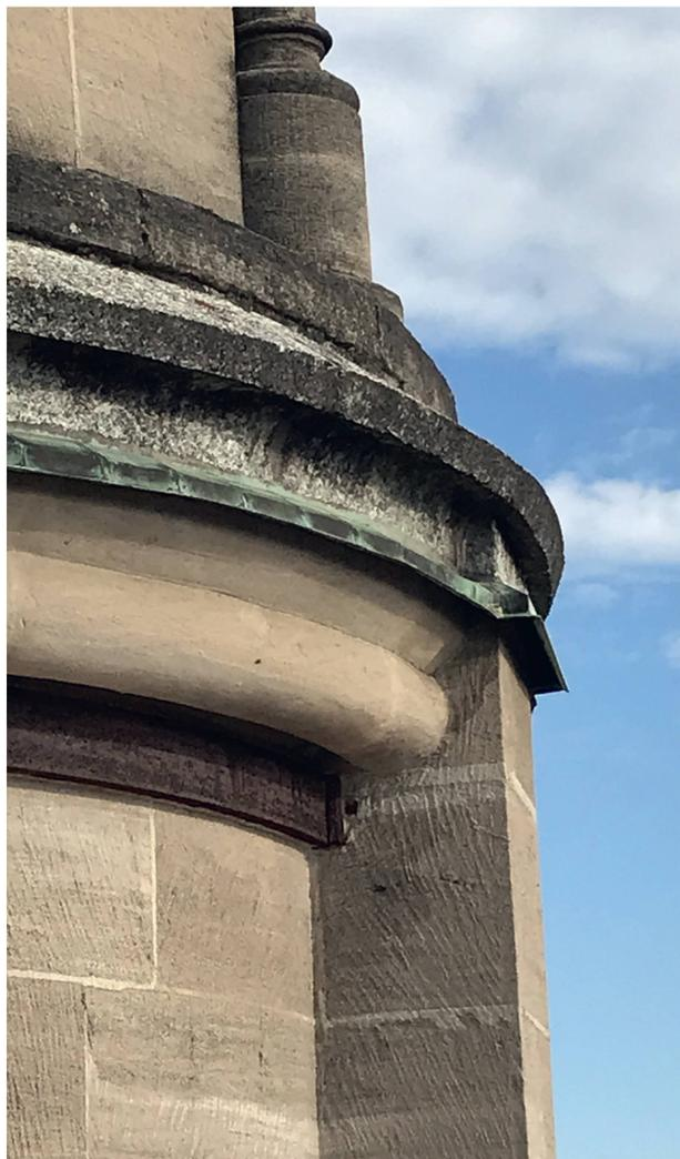
**17** Tour du beffroi, stylobate de la tourelle nord-est; insertion d'un coupe-larme en cuivre entre deux assises de la corniche talutée, première moitié du XX<sup>e</sup> siècle; l'efficacité du larmier de ferblanterie se mesure à la différence de développement micro-organique qu'il y a entre les pierres situées au-dessus de la ferblanterie et celles qui se trouvent au-dessous (photo Amsler Dom arch., 2020).
