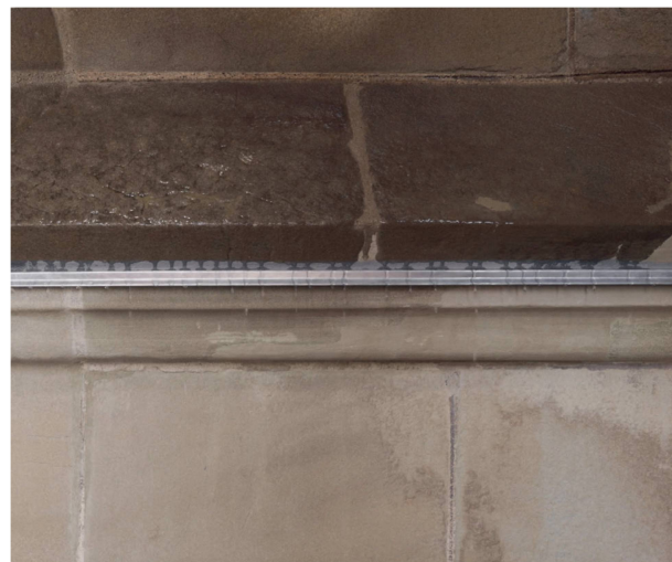
11 Mouchette de tôle dans le joint inférieur du cordon en fonctionnement lors d'essais in situ (photo Jeremy Bierer, 2021).
