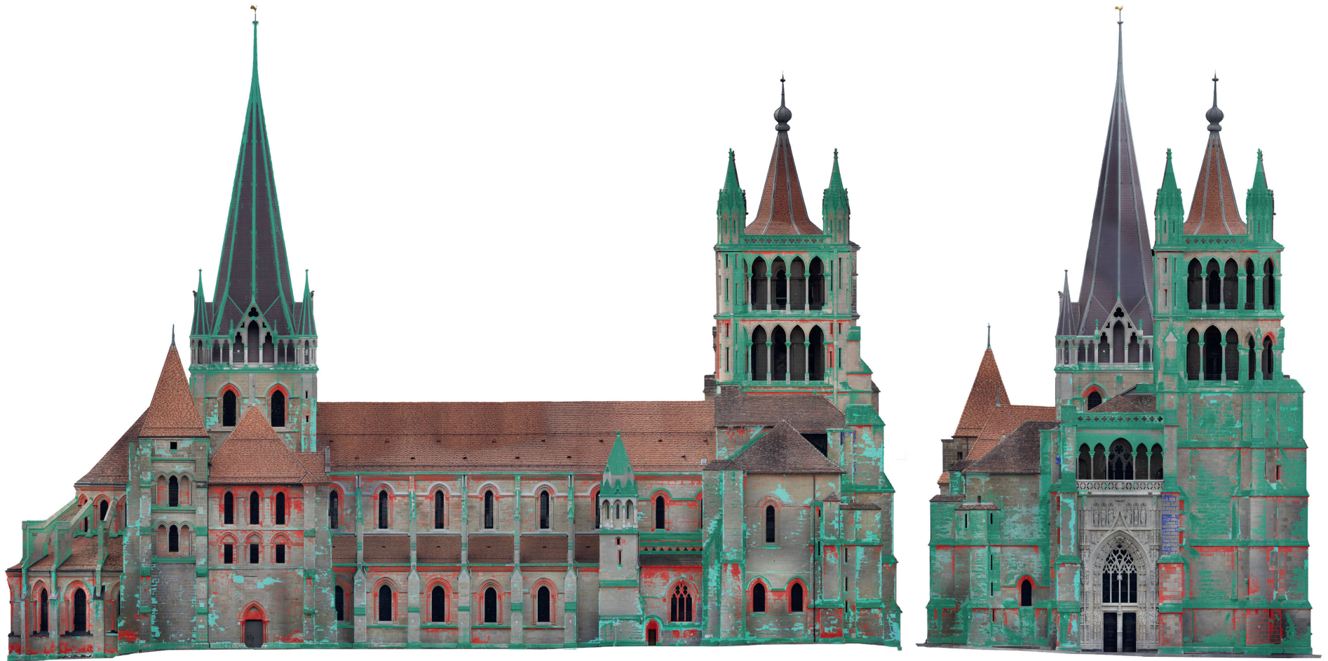
C3 Pathologies des façades nord et ouest : la façade ouest est particulièrement atteinte par les colonisations biologiques, à cause de la direction des vents provenant du nord-ouest.
