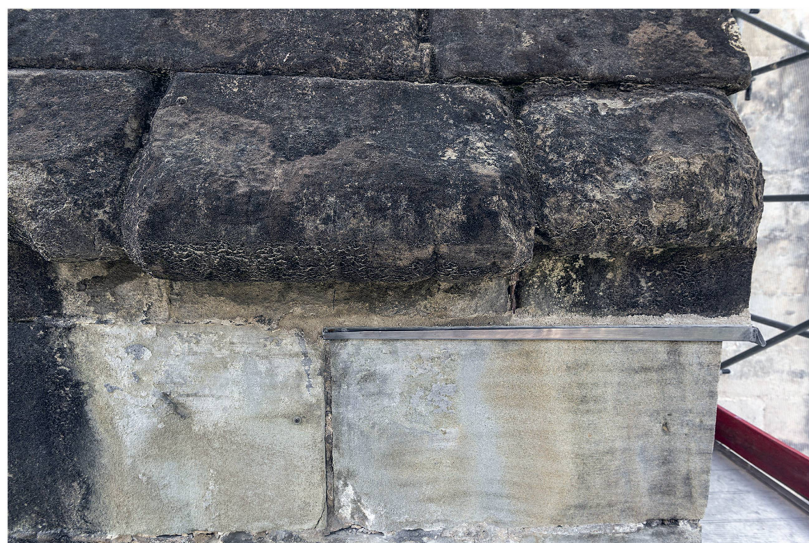
3 Le même élément après équipement d'une coulisse de ferblanterie (photo Claude Bornand, 2021).
