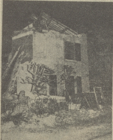
Die Südansicht des zerstörten und eingestürzten Hauses an der Limmatstrasse in Zürich. (Vl. Dr. 1912)
