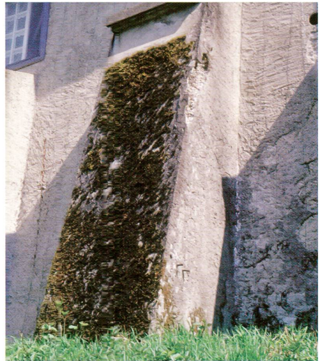
Abb. 20: Orthotricho-Grimmietum pulvinatae an einem Strebepfeiler am Gebäude NE des Französischen Gartens. Man beachte das vor Regen geschützte, stets trocken bleibende und deshalb moosfreie Mauerstück unterhalb des Vorsprungs.
