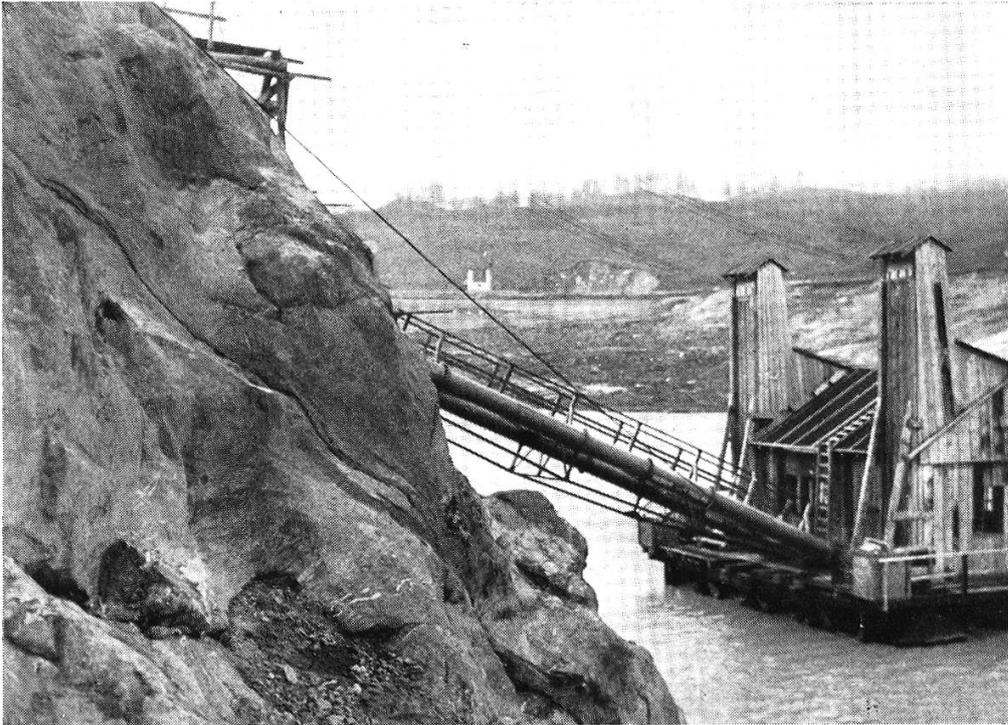
Fig. 1. Schluchtwand mit Erosionskesseln, sichtbar bei maximaler Absenkung des Sees im Herbst 1923. Der obere Rand der Wand liegt normalerweise 10 m unter Seespiegel.
