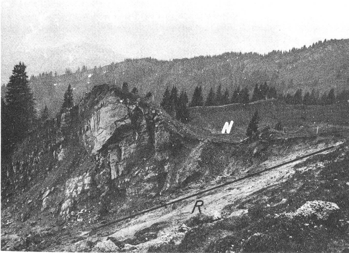
Abb. 3: Oberes Nackental (N), Abrisswand und Rutschfläche R
