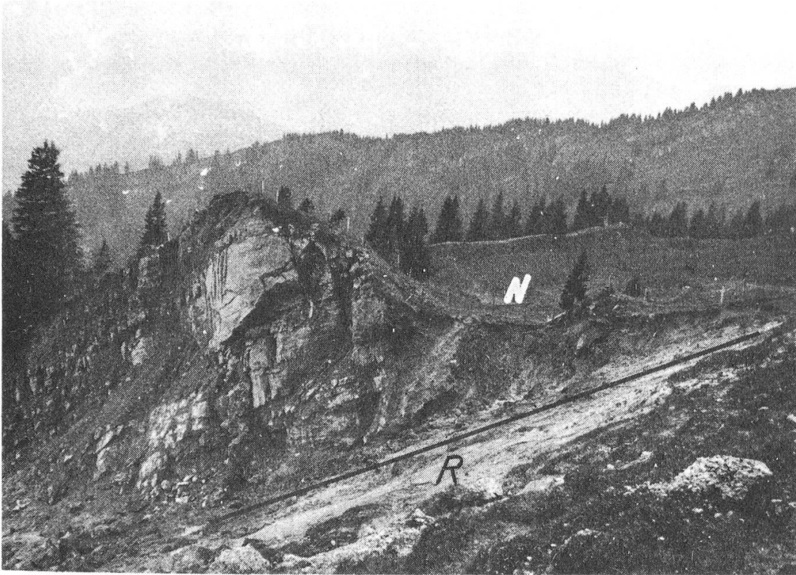
Abb. 3: Oberes Nackental (N), Abrisswand und Rutschfläche R
