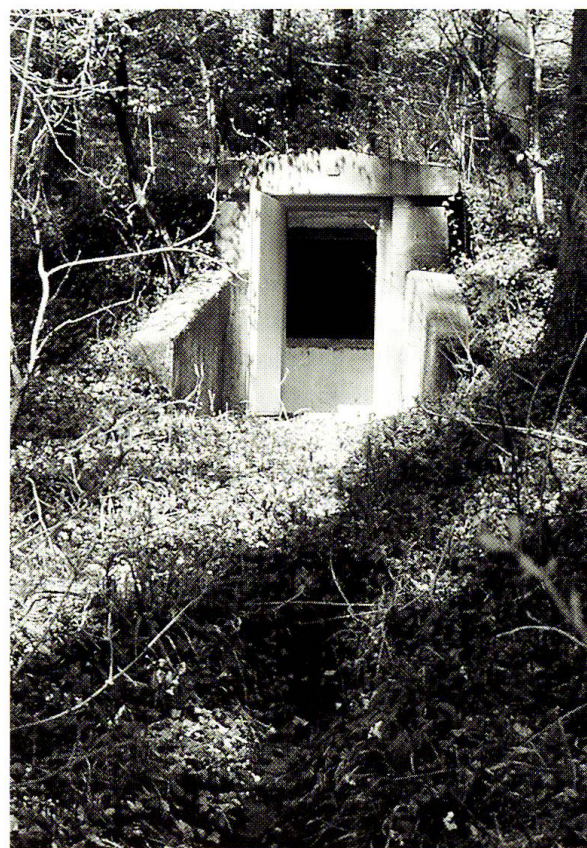
Abb. 3: Brunnenstube mit Überlauf der Quellwasserfassungen Tannberg im Chommlibachtobel. Die Tannberg-Quellen (Wasserversorgung Sursee) liefern 90 bis 300 Liter Quellwasser pro Minute.
