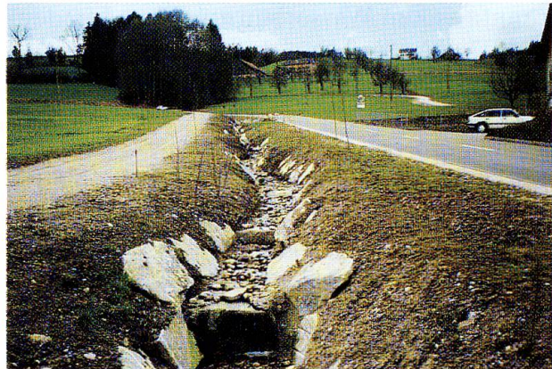
Abb. 8: Situation unmittelbar nach der Bachöffnung, 4. 3. 1995.
