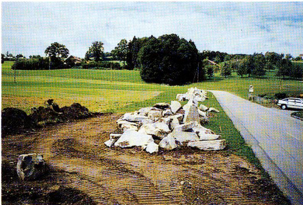
Abb. 7: Bognauerbach, Gemeinde Oberkirch: Situation während den Bauarbeiten, 14. 9. 1994.
