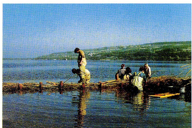
Abb. 24: Sempachersee, Gemeinde Sempach: Lahnungen mit Weidenfaschinen als Wellenbrecher, 3. 5. 1994.
