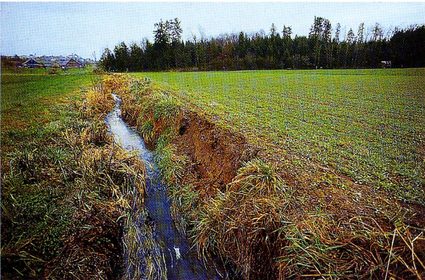
Abb. 6: Herrenmühlbach vor der Einmündung in den Stägbach in einem stark beeinträchtigten Zustand. Die steile und gehölzlose Böschung ist erosionsanfällig.
