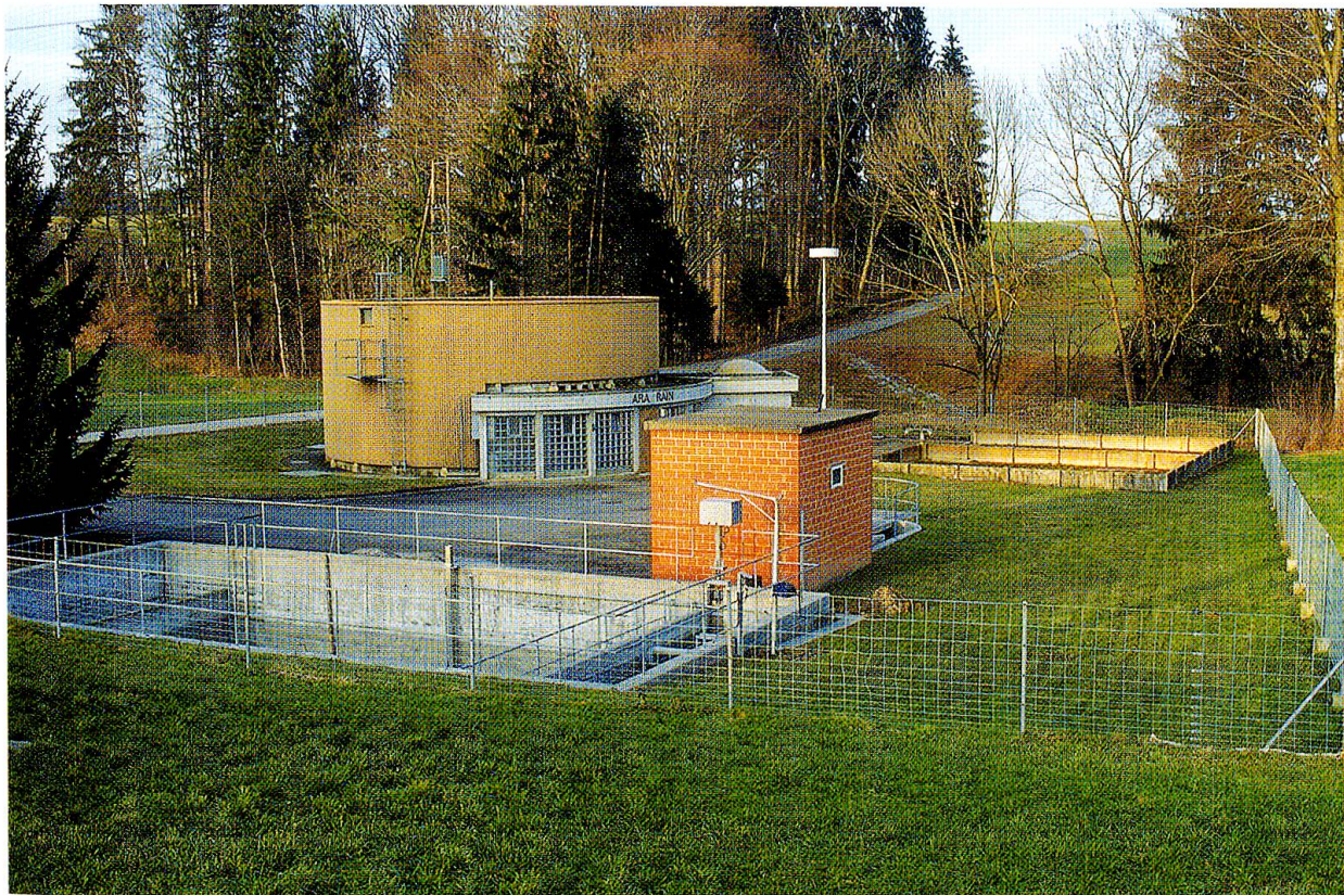
Abb. 1: ARA Rain, aufgehoben im August 2000.
