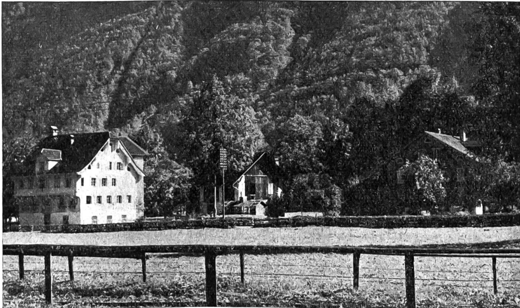
Bisheriges Waisenhaus (links) und ehemalige Dechwanden-Anstalt (rechts).
