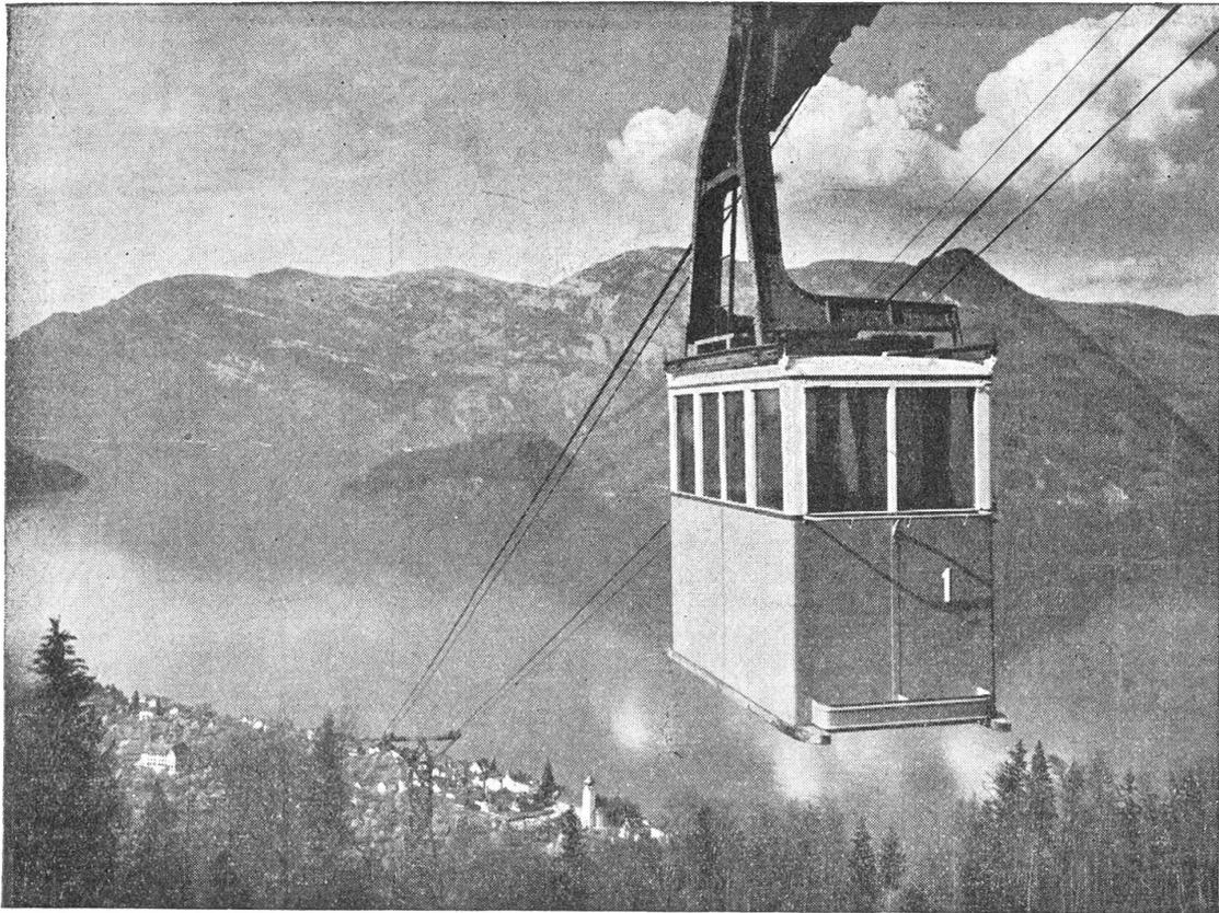
Von acht pyramidenförmigen Eisenmasten werden die Seile getragen, die im Pendelverkehr mit einer Geschwindigkeit von 4 Metern in der Sekunde gleichzeitig Berg- und Talfahrt vermitteln. Dabei wird eine Höhendifferenz von 1146 Metern überwunden. Die Laufbahn ist 3110 Meter lang. Die Tragseile, je aus einem Stück, sind 34 mm dick und vollverschlossen. Es ist gebildet aus 61 Rundferndrähten und 22 Profildrähnen. Jedes Seil wiegt über 400 Zentner.
