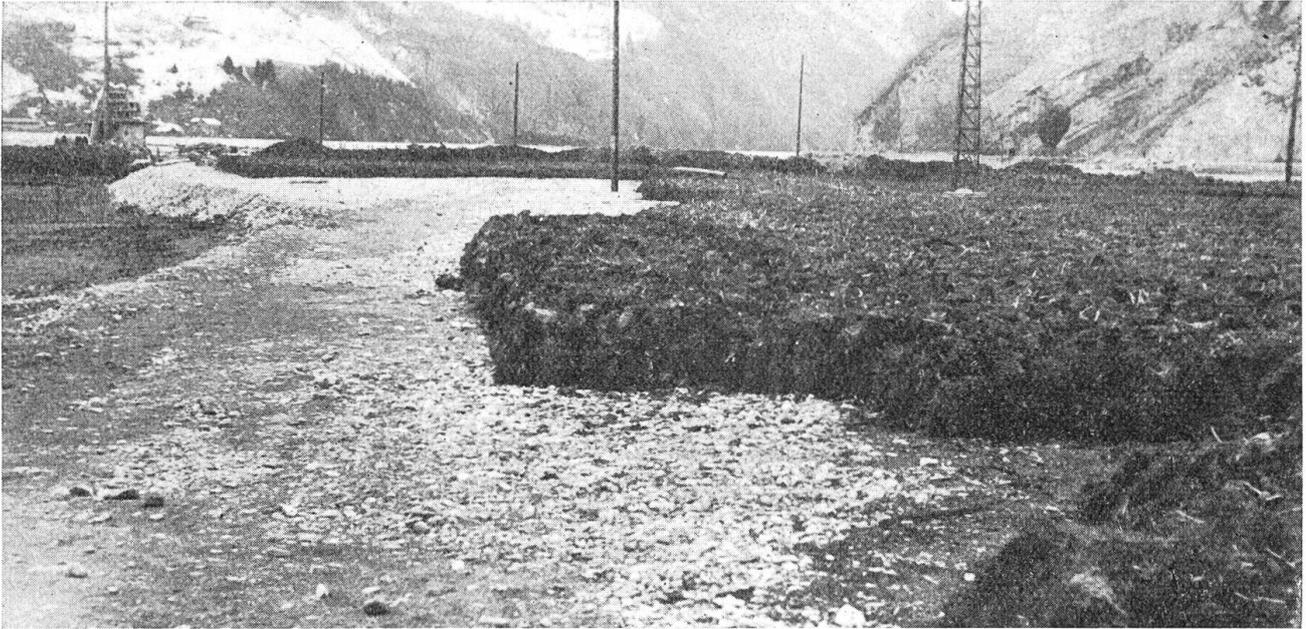
Dieses Bild zeigt die verschiedenen Arbeitsetappen. Links sieht man ein Stück des unbearbeiteten Riedes, in der Mitte die aufgeschüttete Gesteinsauflage, rechts die inzwischen getrocknete, aufgestockte Erde, welche aus dem See gehoben worden ist
