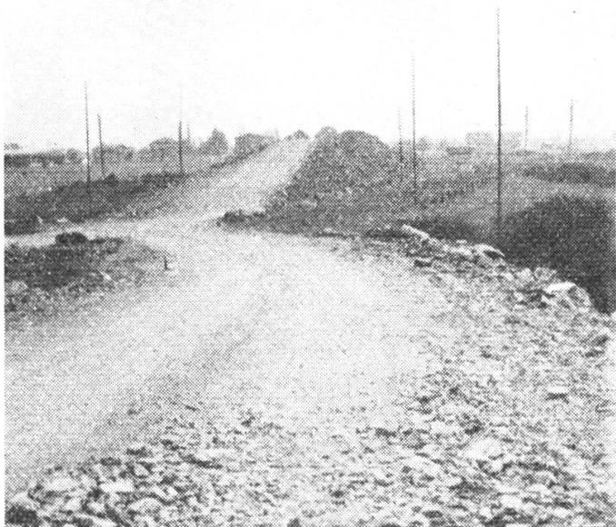
Diese Aufschüttung ist der Beginn des Dammes von 1,5 km Länge. In der Mitte entsteht die Eisenbahnbrücke von 85 m. Sie führt über den Feldweg, Autobahn, Kanal und Rotzlochstrasse. Ihre lichte Höhe beträgt 4,5 m.
