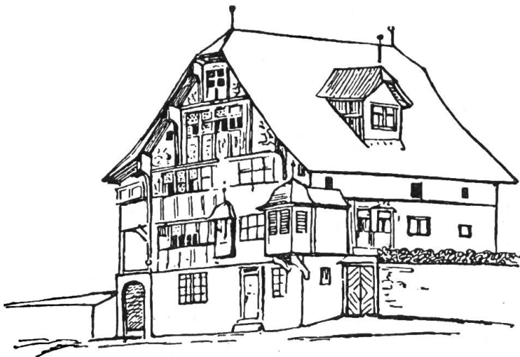
Das ehemalige Keyser Haus an der Nägeligasse
