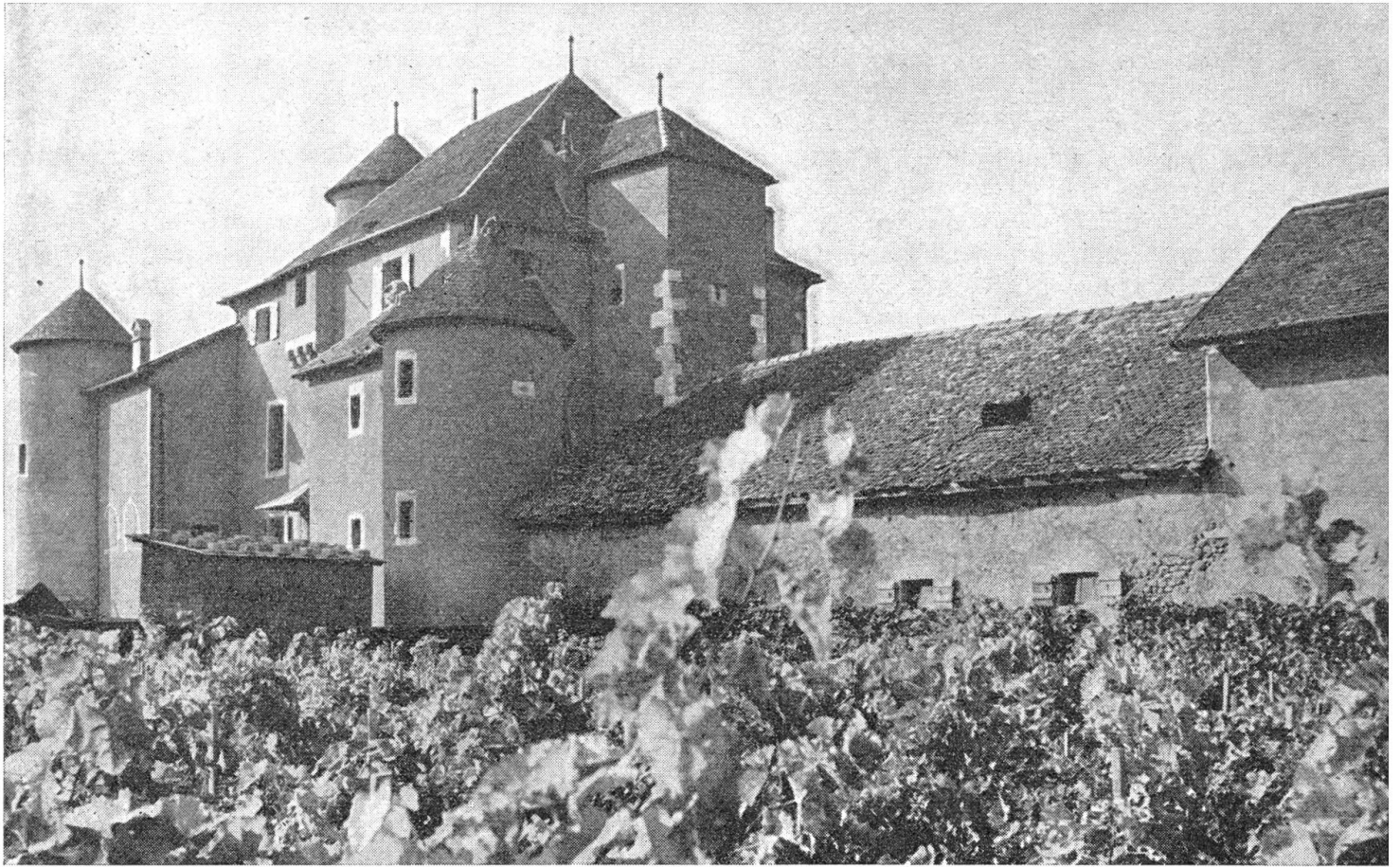
Die ehemalige Johanniterkomturei von Compièrès wurde mit Unterstützung des «Schweiz. Heimatschutz» sehr gediegen renoviert.
