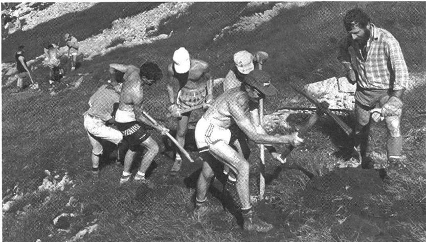
**7. PTT-Lehrlinge leisteten Berghilfe.** Im Brisengebiet, in rund 2000 Meter Höhe, bauten die PTT-Elektroniker-Lehrlinge für die Alp Unterstock eine rund 400 Meter lange Wasserleitung. Die strengen Arbeiten in der steilen, steindurchsetzten Plangge, waren für die Elektroniker, die sich vor allem an feine Handarbeit gewöhnt waren, eine echte Herausforderung. Unser Bild: Die Lehrlinge leisteten im steilen Gelände echte Berghilfe.
