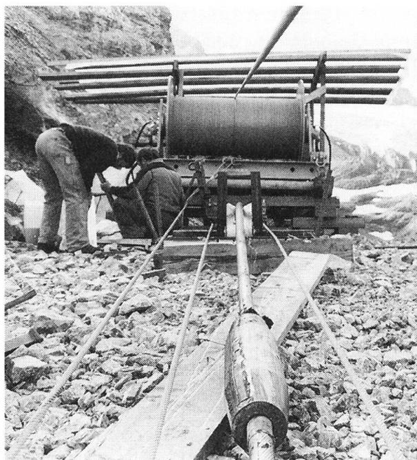
*Im Sommer 1991 wurde mit einem technisch aufwendigen Verfahren die Tragseile mit automatisch schliessenden und öffnenden Seilklemmen impulsförmig von der Gerschnialp zum Stand hochgezogen.*
