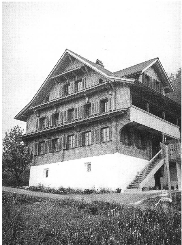
Stansstad. Wohnhaus Stegmatt in Obbürgen. Aussenansicht von Westen nach der Restaurierung.
