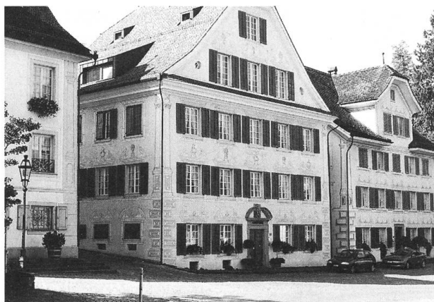
Stans. Zelger-Haus, Rathausplatz 7. Aussenansicht nach der Restaurierung.
