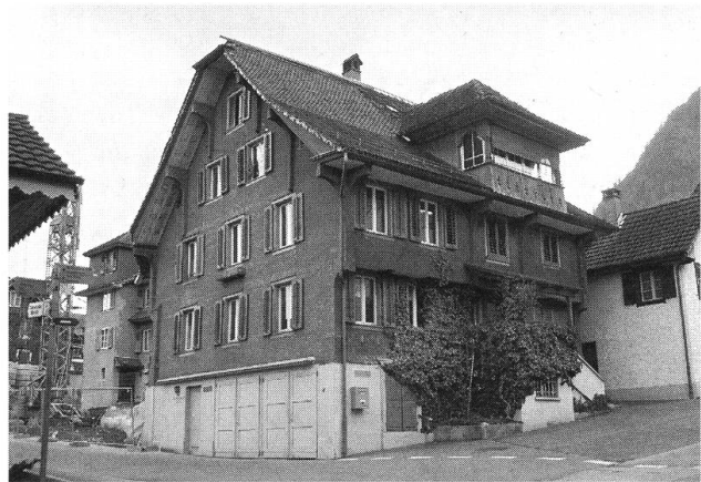
Buochs. Wohnhaus Dorfstrasse 13. Ansicht von Nordwesten. Zustand vor der Restaurierung.
