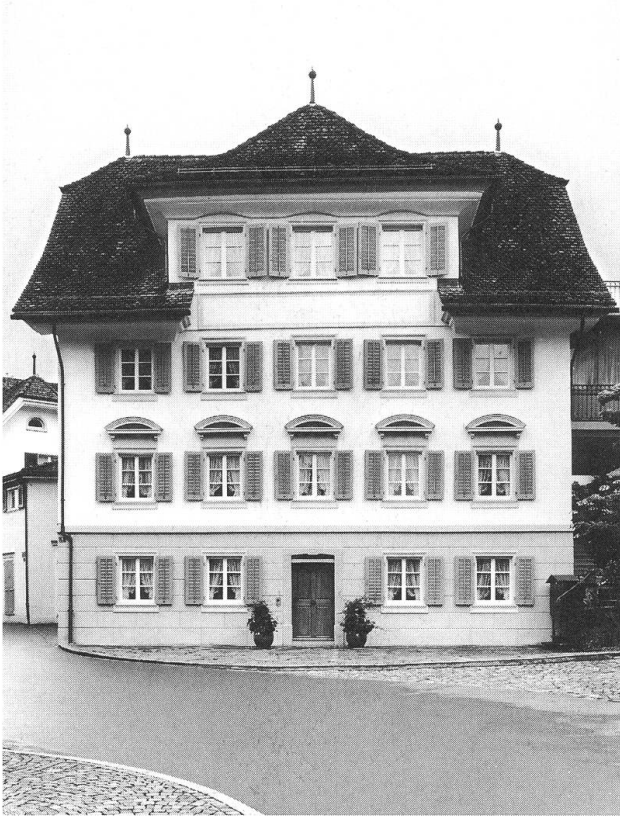
Ansicht von Westen nach der Restaurierung.
