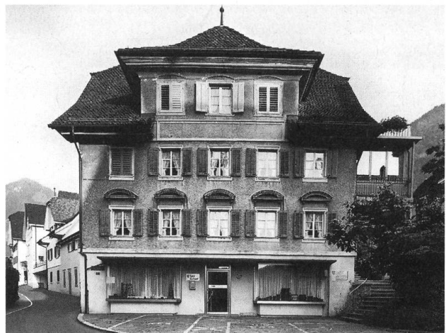
Stans. Haus Fruonz, Rathausplatz 3. Ansicht von Westen vor der Restaurierung.
