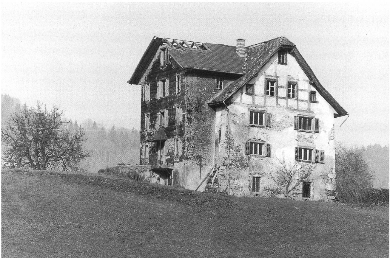
Oberdorf. Haus Hinter Gross Ennerberg. Ansicht von Südosten (abgebrochen 2001)
