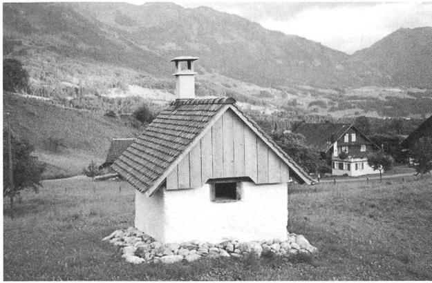
Ennetmoos. Dörr- und Backhaus «Gruobli», Mueterschwandenberg. Ansicht von Norden.
