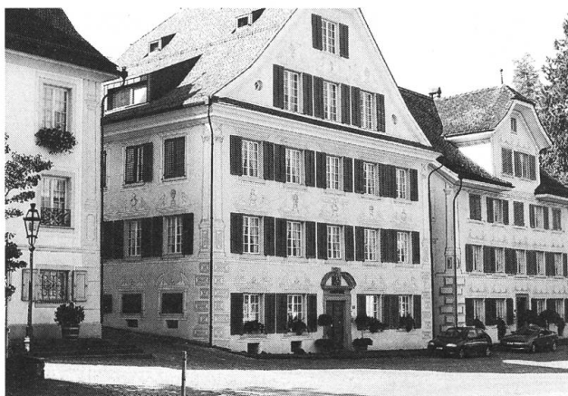
Stans. Zelger-Haus, Rathausplatz 7. Aussenansicht nach der Restaurierung.
