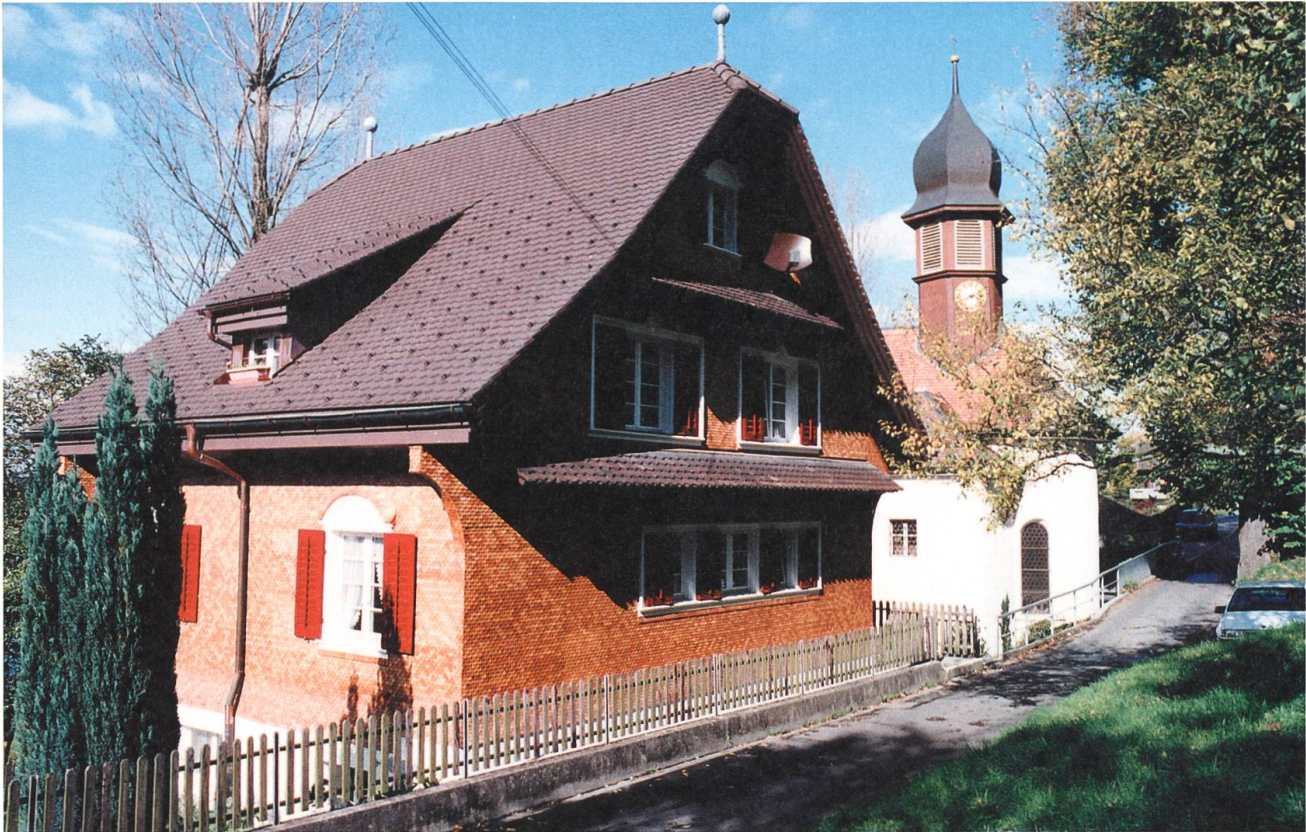
Kehrsiten (Gde. Stansstad) neue Kaplanei; Aussenansicht von Südwesten.
