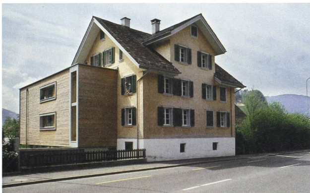
Stansstad, Wohnhaus Schürmatt; Aussenansicht von Osten.
