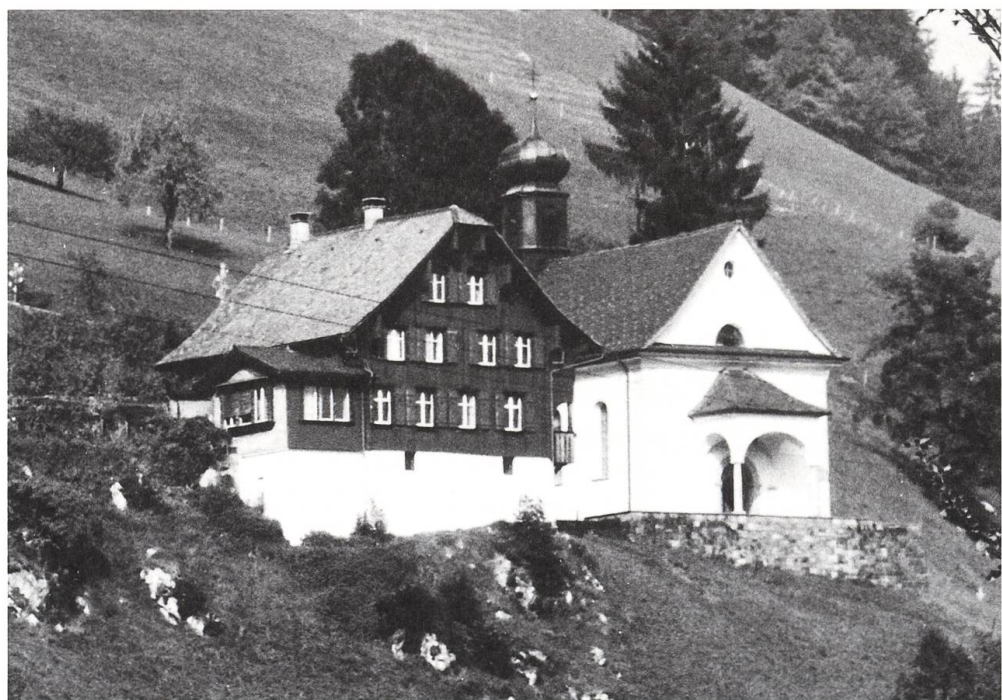
Wiesenberg (Gde. Dallenwil) Kaplanei; Aussenansicht mit Kapelle.
