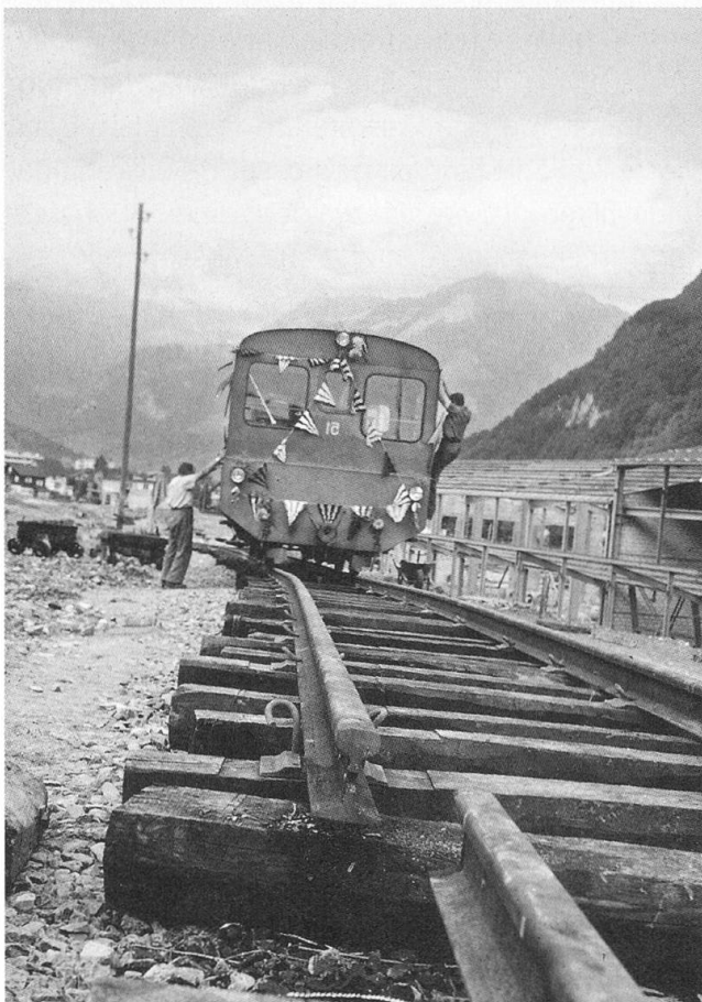
Der Baudiensttraktor steht für die erste Fahrt von Stansstad nach Hergiswil schon bereit. Noch müssen an diesem 20. August 1964 die beiden letzten Laschen an den Schienen angezogen werden.
