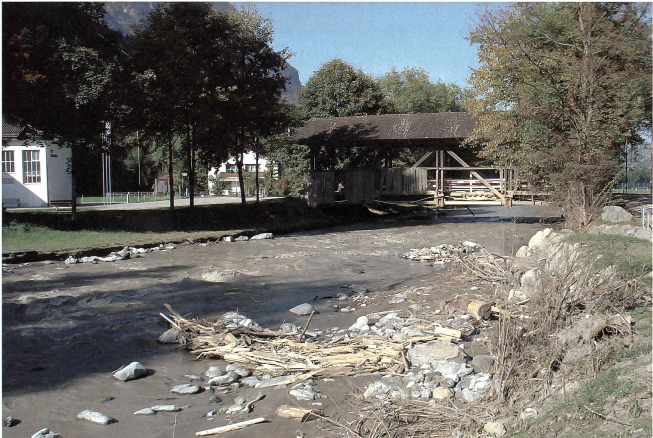
Bei der Brücke Oberau wurde das Tragwerk durch das Hochwasser zerstört.
