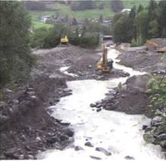
Links: Schon weit oberhalb der Einmündung lagert der Buholzbach in Oberdorf Tausende von Kubikmetern Geschiebe ab (Bild vom 25. August beim Ausbaggern).
