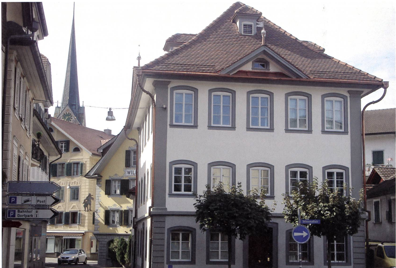
Stans: Wohnhaus Engelbergstrasse 7, Aussenansicht von Osten.
