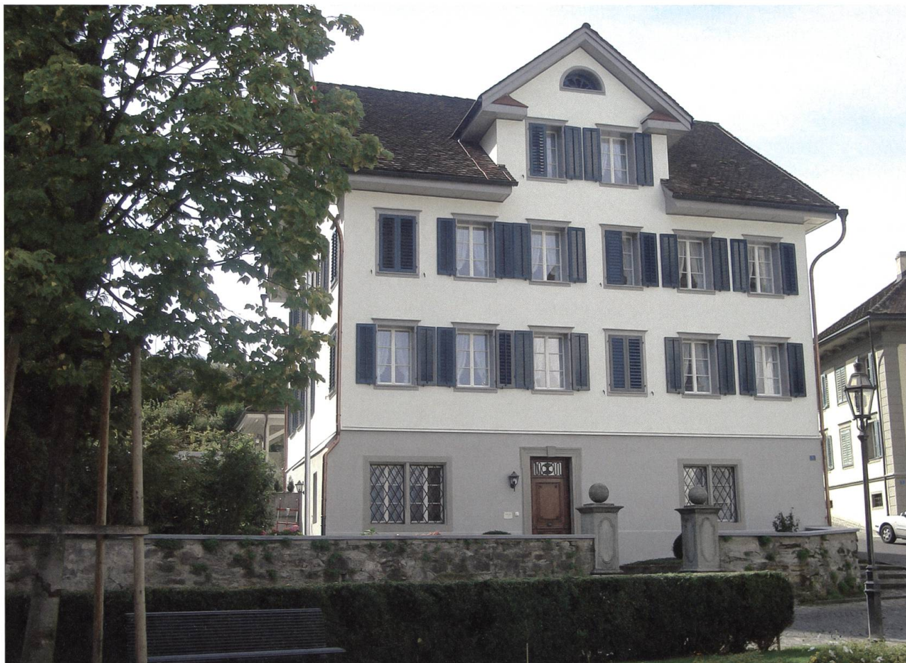
Stans: Pfarrhaus, Aussenansicht von Nordosten.
