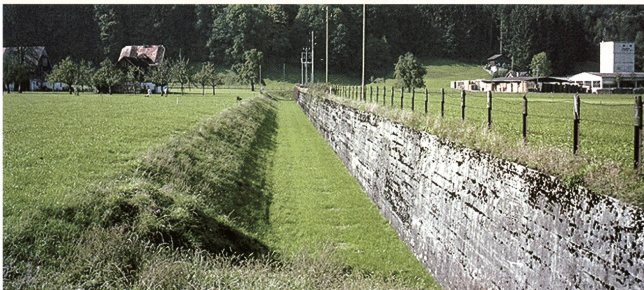
Der Tankgraben am linken Ufer der Engelbergeraai ist heute zugeschüttet.
