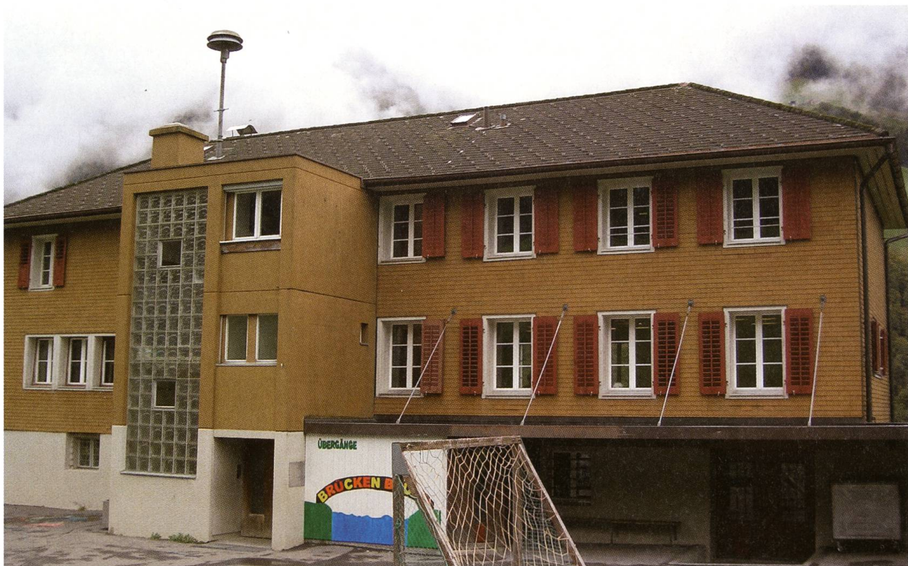
Das Schulhaus Altzellen seit dem letzten Viertel des 20. Jahrhunderts.
