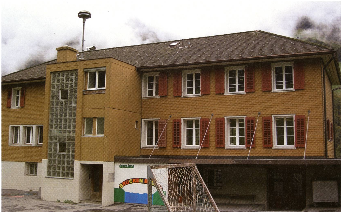
Das Schulhaus Altzellen seit dem letzten Viertel des 20. Jahrhunderts.
