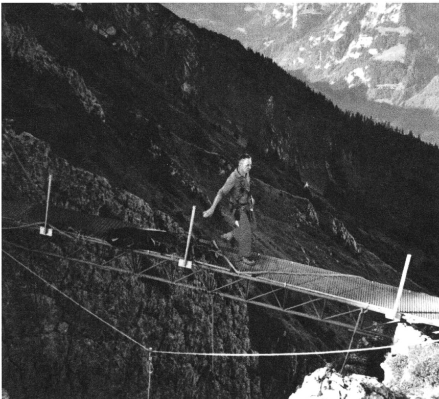
2.10.06 Herzstück ist eingebaut
