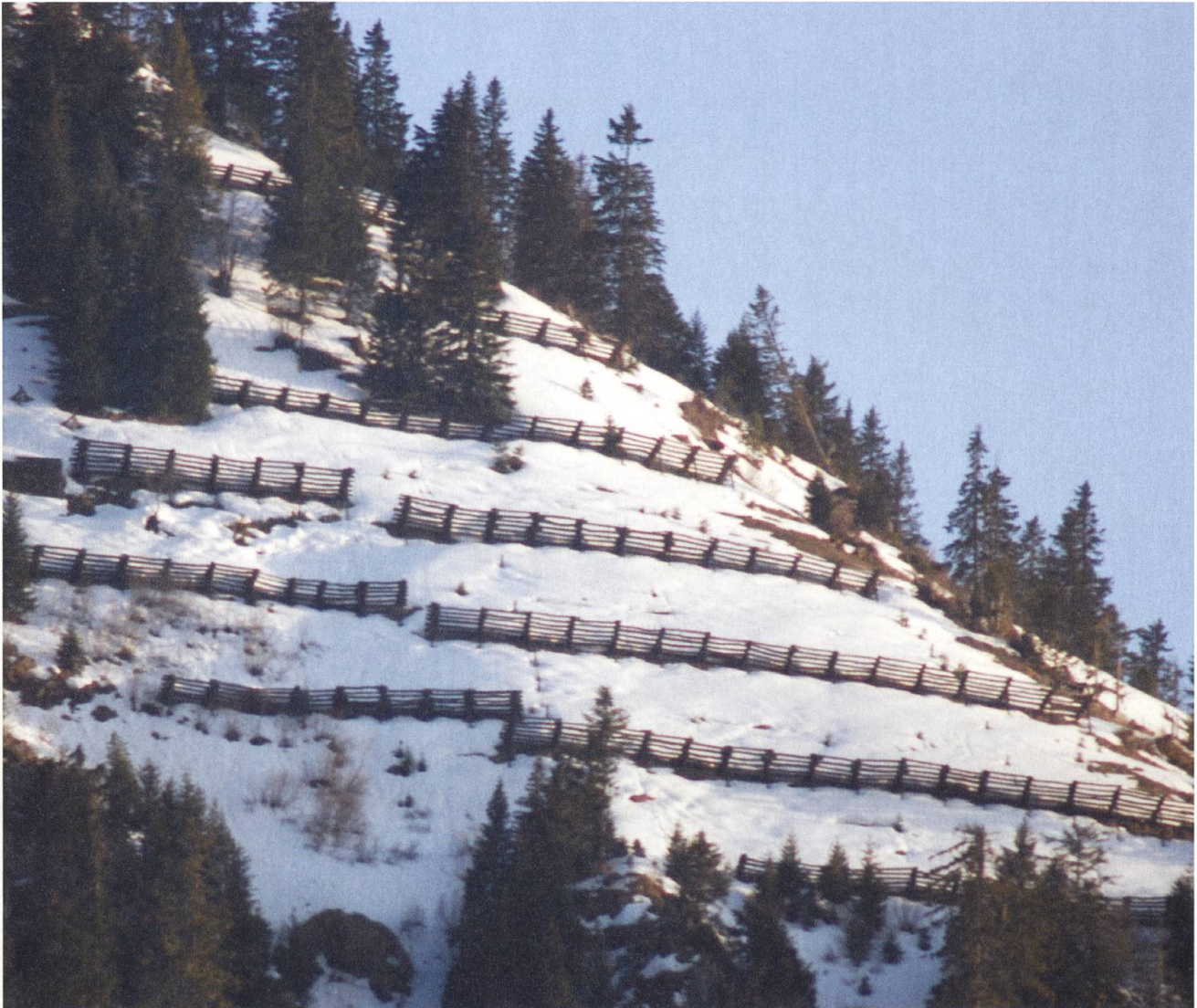
Wo der Wald nicht schützt, muss aufwendige Technik nachhelfen – wie mit Lawinerverbauungen am Stanserhorn.
