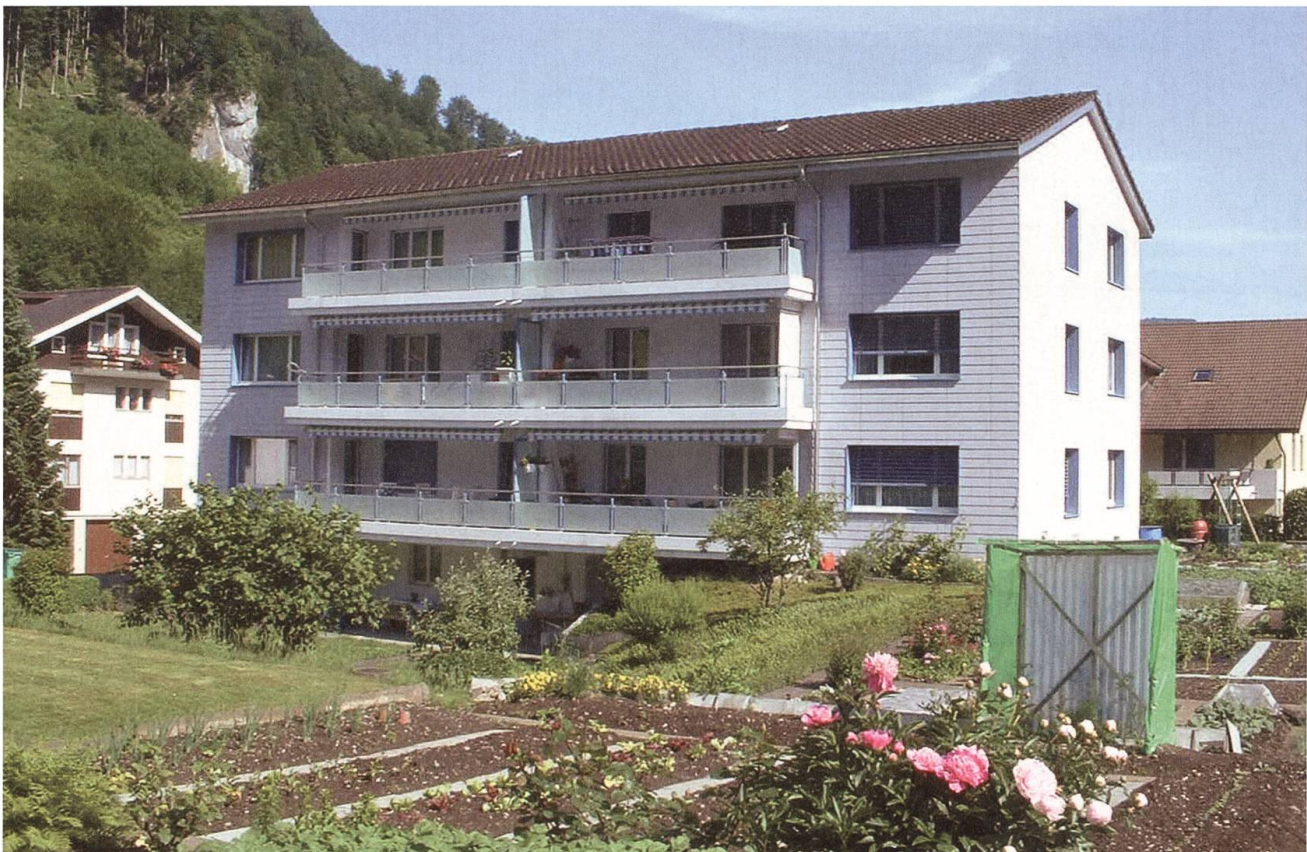
Die Mehrfamilienhäuser an der Allmendstrasse schaffen einen Wert, der über Generationen hinaus bestand hat.
