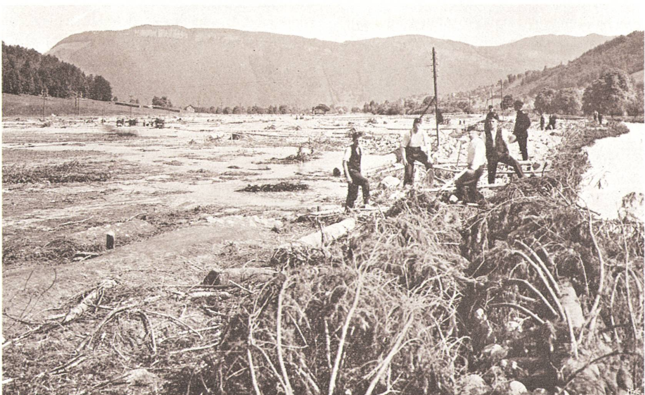
Freiwillige Helfer erstellen einen Notdamm, um die Allmeind zu schützen.
