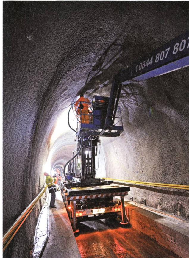
Der Tunnel wird mit Spritzbeton ausgekleidet.
