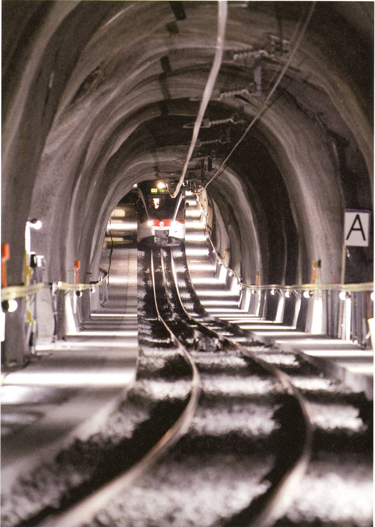
Sicher und schnell durch den Tunnel: Kurz vor dem bergseitigen Südportal an der «Boden»-Kurve.
