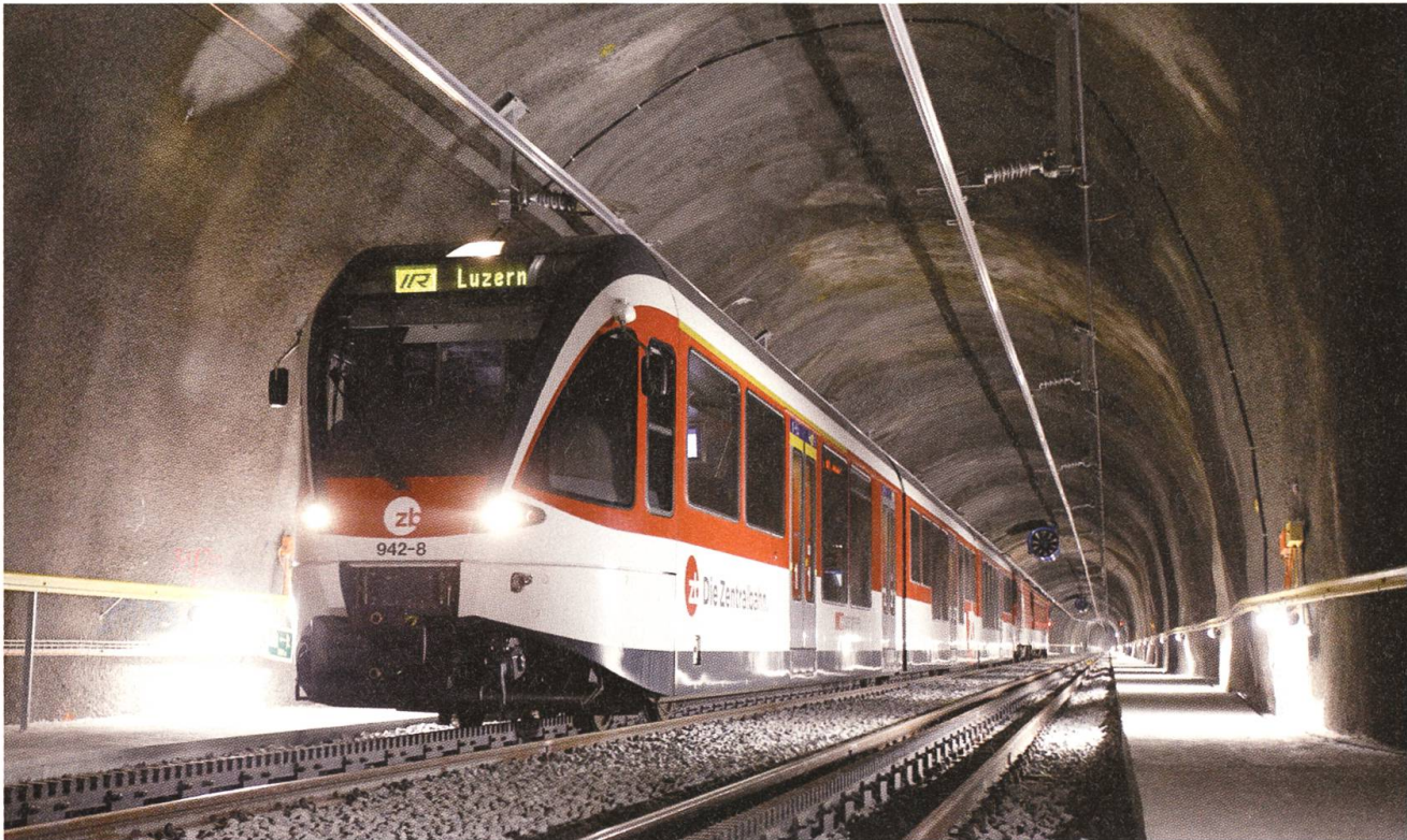
Im Tunnel können zwei Züge an zwei Stellen problemlos kreuzen.
