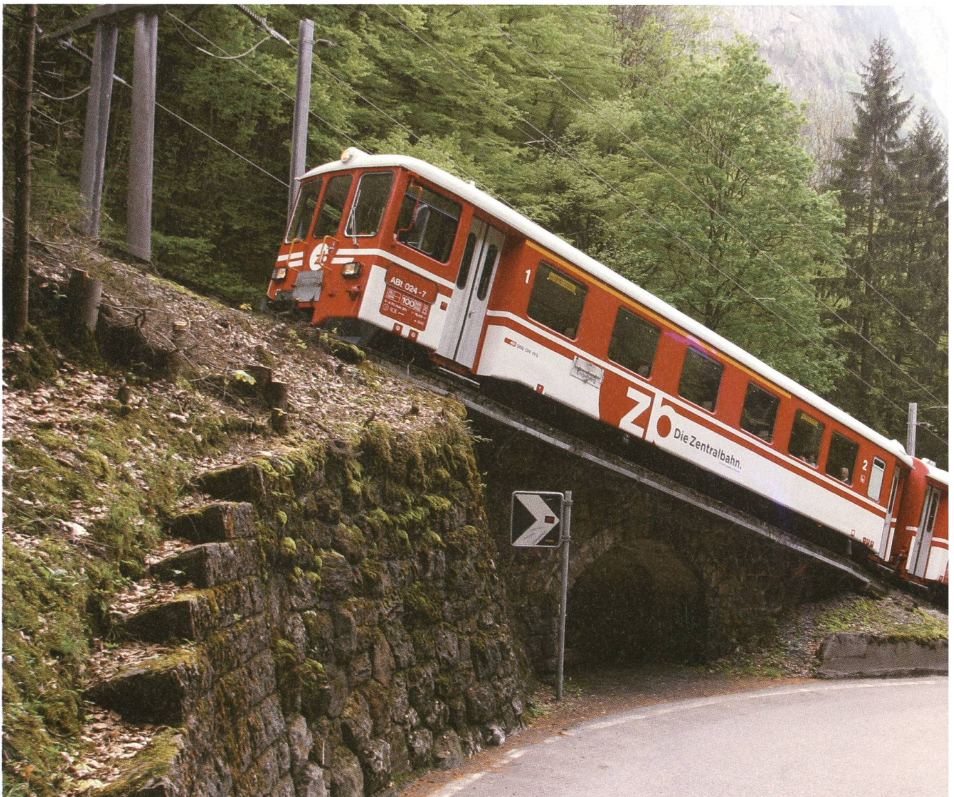
Auf dem Weg nach Engelberg hatte die Zentralbahn bisher eine enorme Steigung überwinden müssen.
