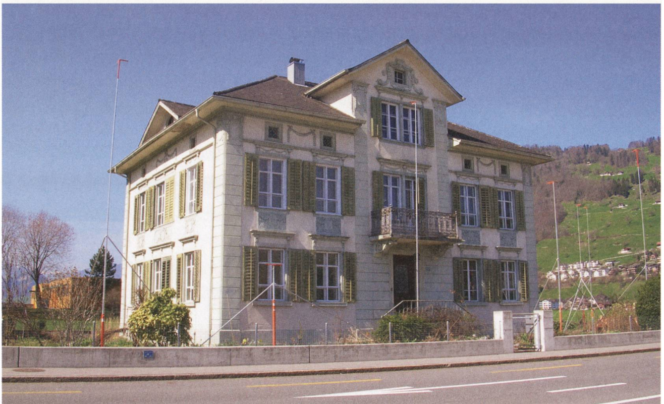
Vorher: Buochs, Wohnhaus Ennetbürgerstrasse 53, sogenannte Direktorenvilla, abgebrochen 2006.
