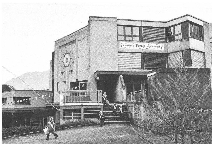
22.8. Das Schulhaus Morgenstern in Ennetmoos.
