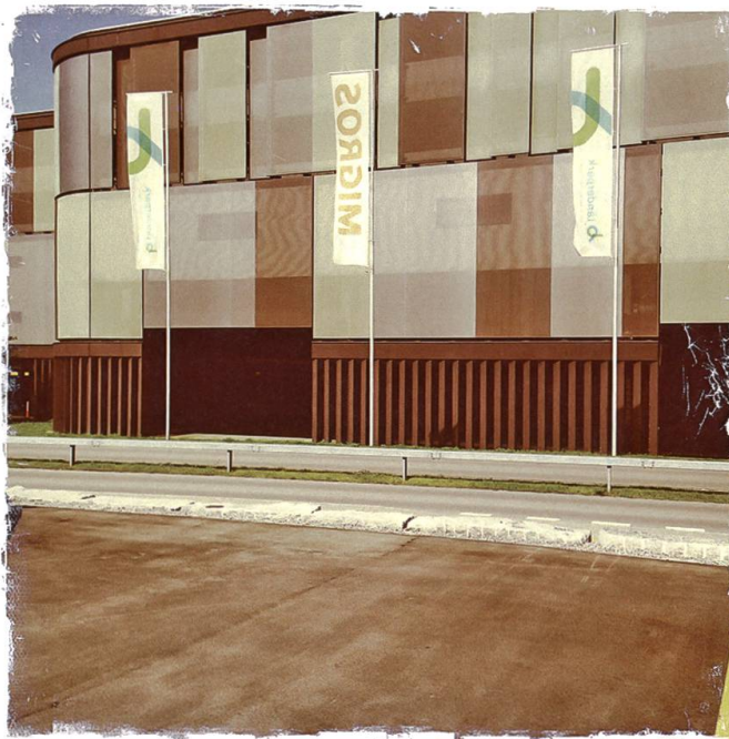
Die hübsche Fassade des Länderparks ist auf Fernwirkung angelegt. Aus der Nähe verliert sie an Qualität. Sie wirkt abstrakt und ohne Leben.
