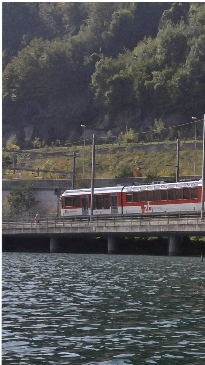
Hauptverkehrsader: Die Zentralbahn, hier bei Horw, ...
