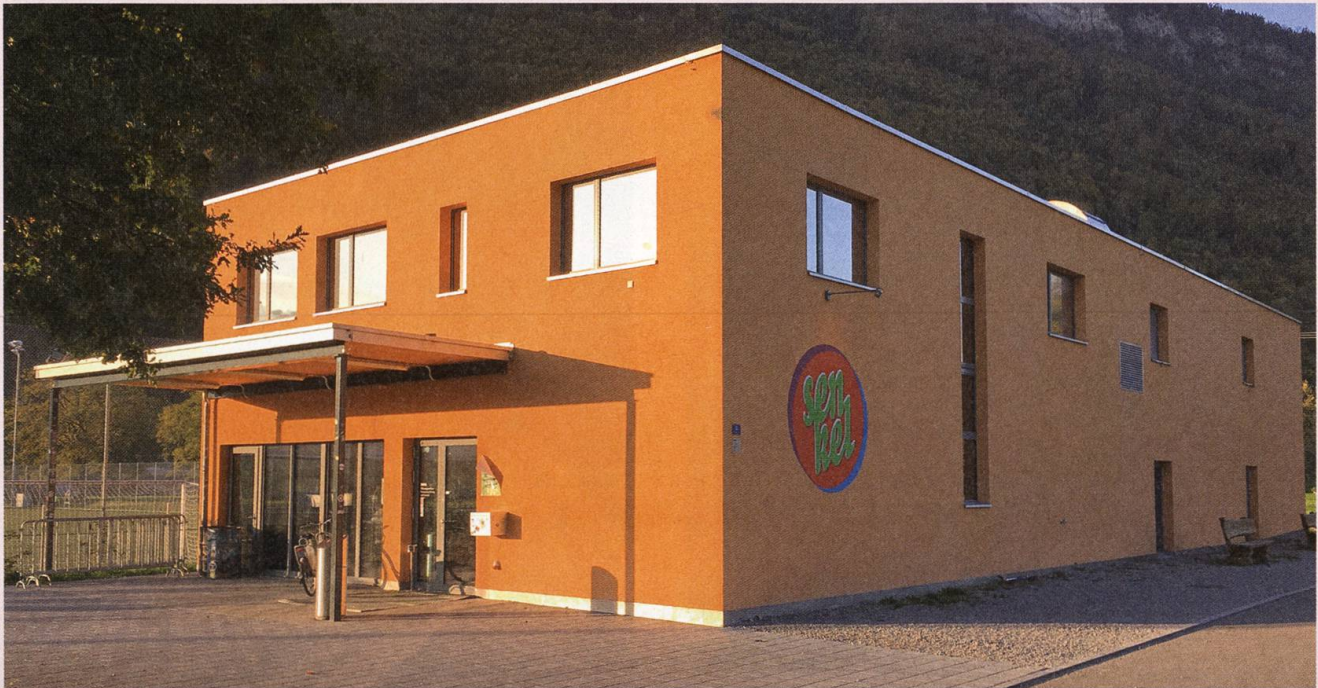
Der Senkel – das orange leuchtende Kulturhaus im Stanser Schwibogen.
