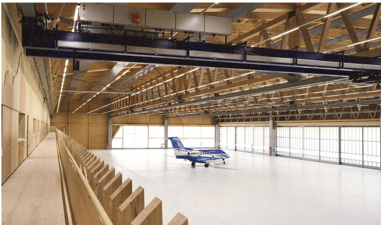
Die 2017 in Betrieb genommene, stützenfreie Halle 25 der Pilatus-Flugzeugwerke in Stans ist eine holzbautechnische Meisterleistung aus einheimischem Holz.
