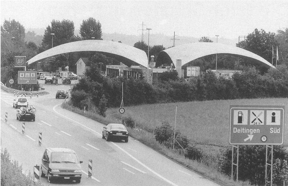
Deitingen, Kanton Solothurn, BP-Tankstelle mit Isler-Schalen
