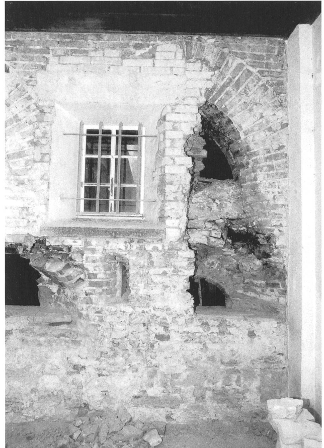
Schloss Interlaken, Sichtbacksteinmauerwerk mit Spitzbogenöffnungen, um 1480. Unten, spätere Einbauten von Backöfen; oben, neueres Fenster. Schloss Interlaken, Zeichnerische Erfassung der Fundsituation.
