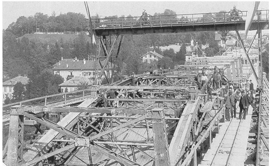
Kornhausbrücke, auf dem Lehrgerüst wird der Stahl- bogen montiert (1897)
