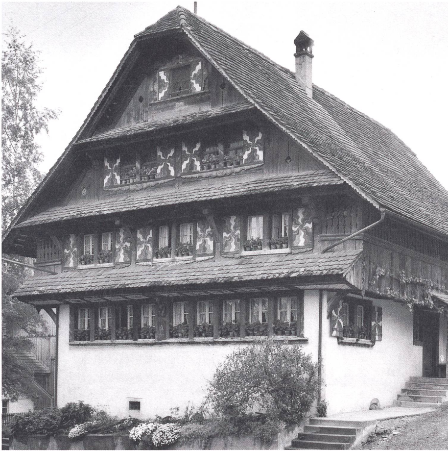
Das 1791 erbaute Koch-Haus in Büttikon AG: Zweigeschossiger Ständerbau mit dreifachen Klebedächern und steilem Krüppelwalmdach.
