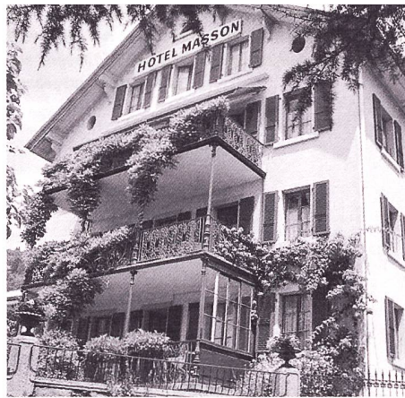
Veytaux, Hôtel Masson: Die Pension Masson entstand um 1850 durch den Umbau eines älteren Winzerhauses in der Nähe von Schloss Chillon am Genfersee.
