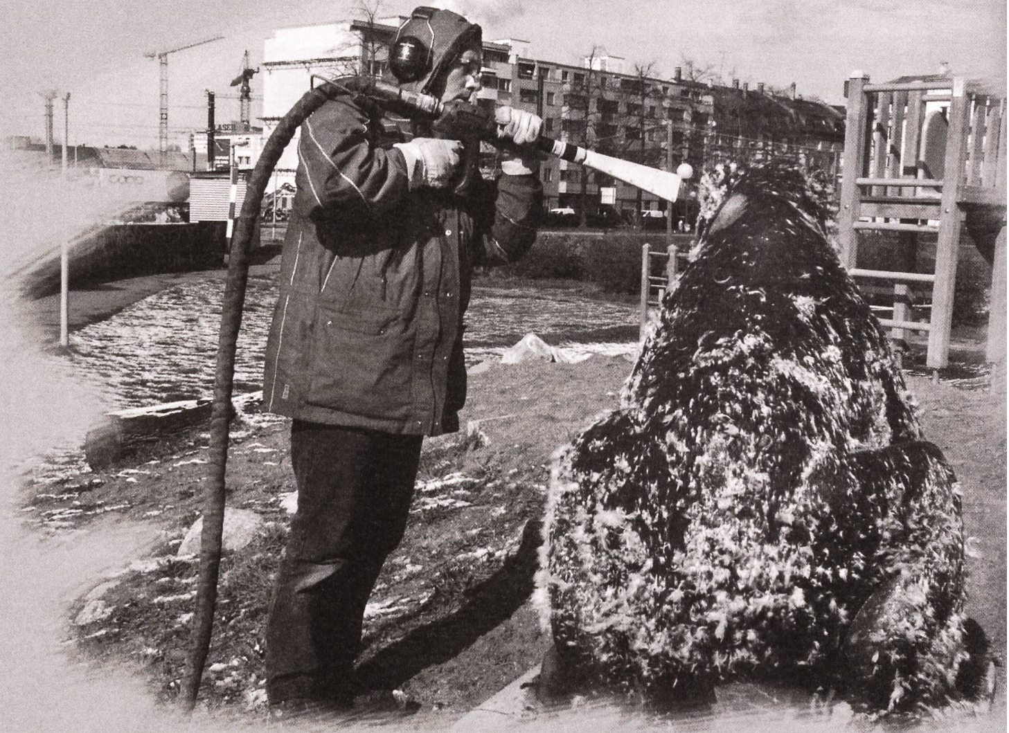
Grobreinigung mit Trockeneis eines mit Bitumen verschmierten Bären aus Marmor im Basler Voltapark.
